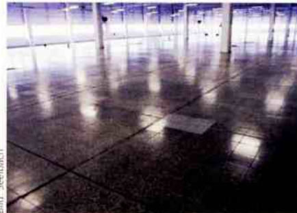
Die sanierten Betonwerkstein-Platten der Birkenstock-Produktionshallen im sächsischen Schönbach.
